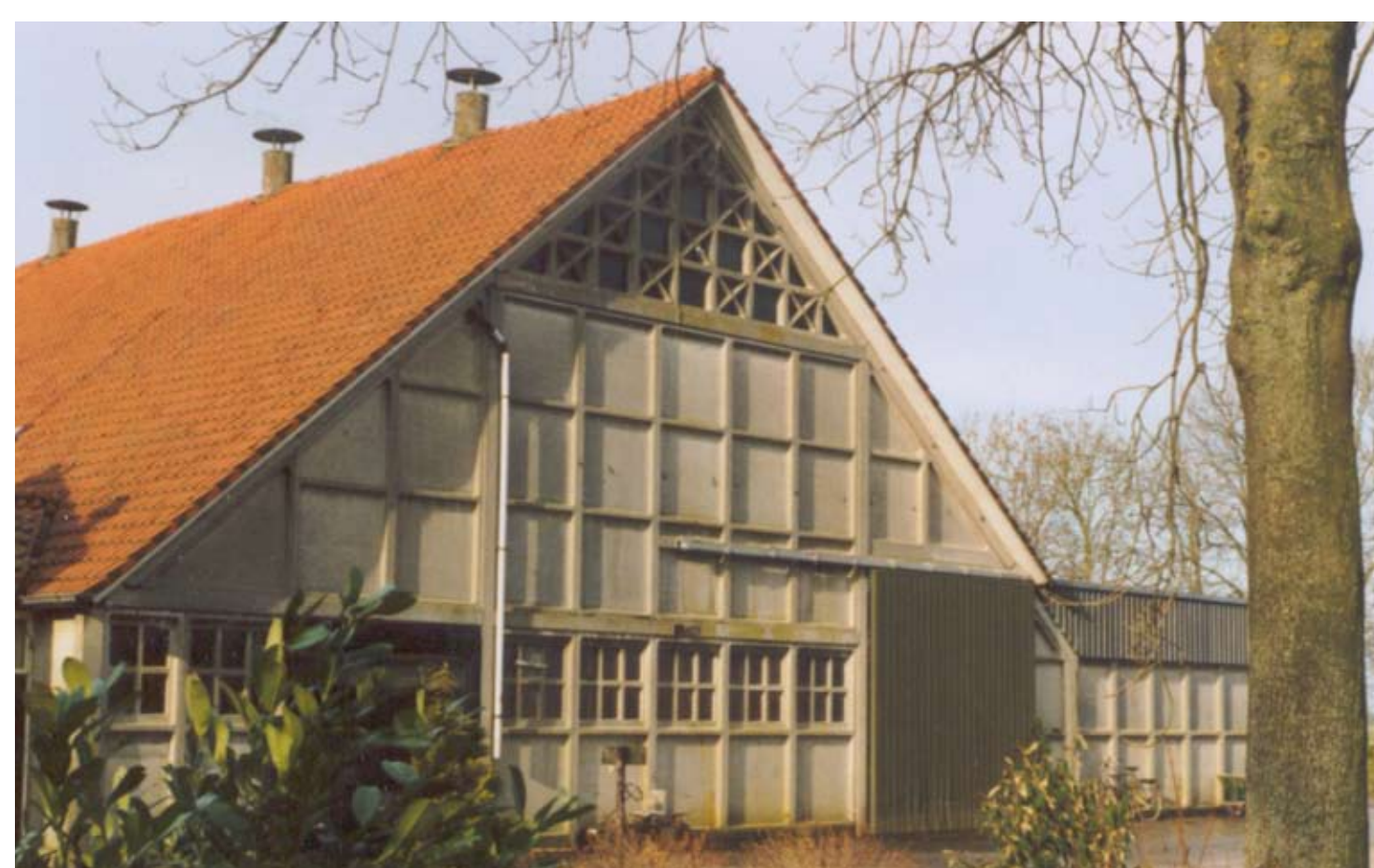
Schokbetonboerderij, ribben zijn duidelijk zichtbaar
