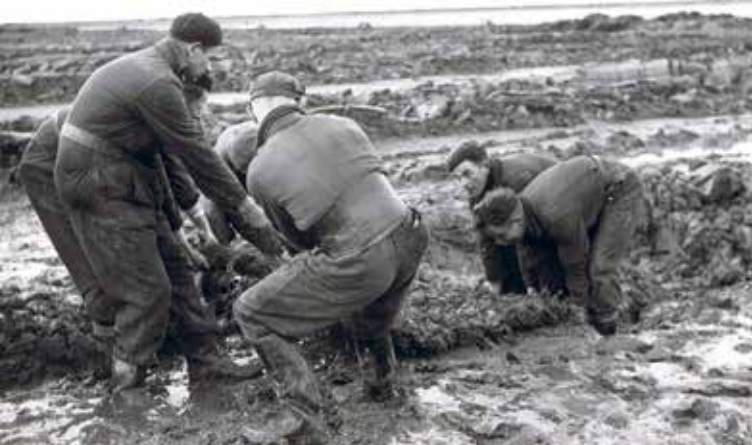
Aan de rand van de polder moesten bij het trekken van greppels stobben worden verwijderd, 1958 (foto Lies Gielen; Erfgoedpark Batavialand).
